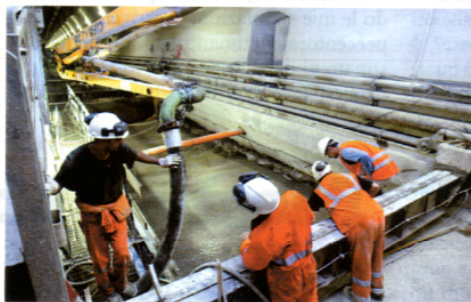
Galleria per l'Alta velocità a Sesto Fiorentino. Sopra: un cantiere della Tav in Val di Susa
